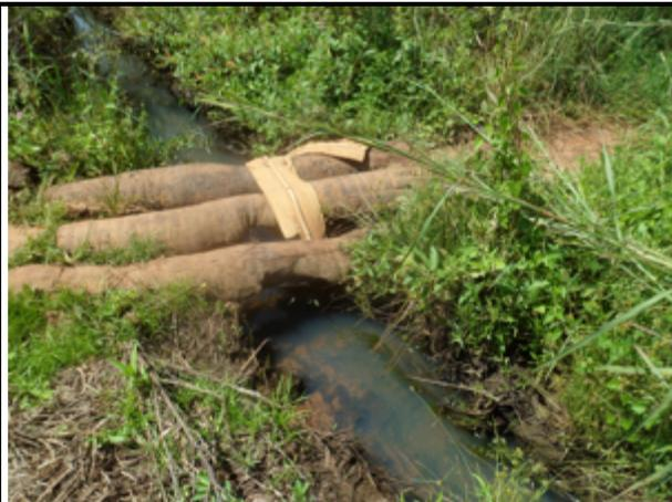
Saturation du remblai et l'écoulement de l'eau sur les deux parois vers le fond du canal (avant réhabilitation)
