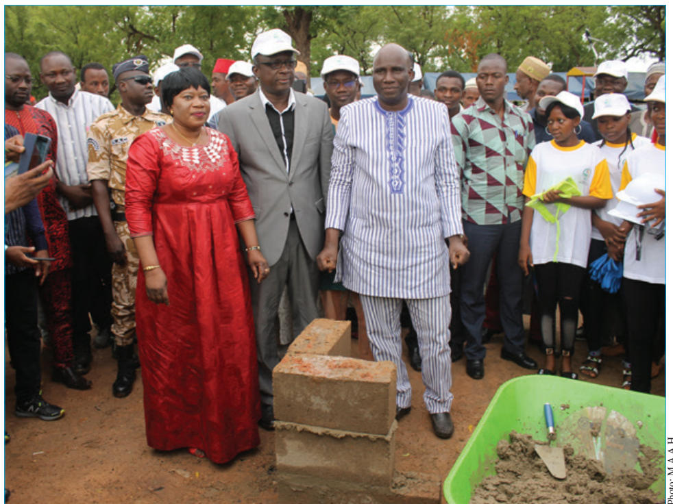
Le ministre Salifou OUEDRAOGO a posé la première pierre d'infrastructures économiques à Léo
