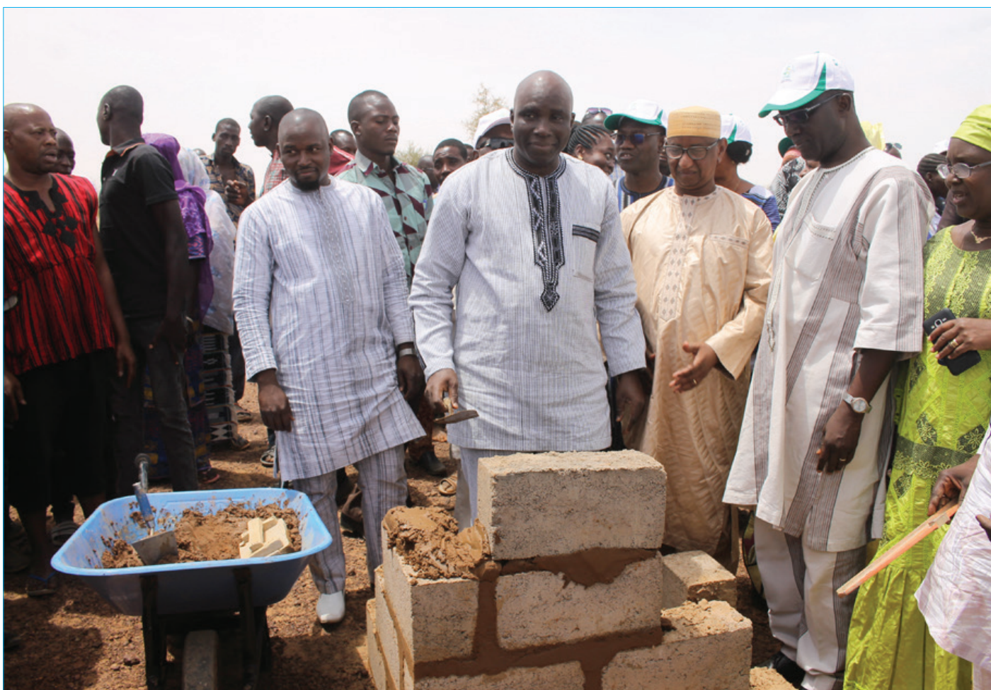
Le ministre Salifou OUEDRAOGO a posé la première pierre de la construction du marché de Sissamba
