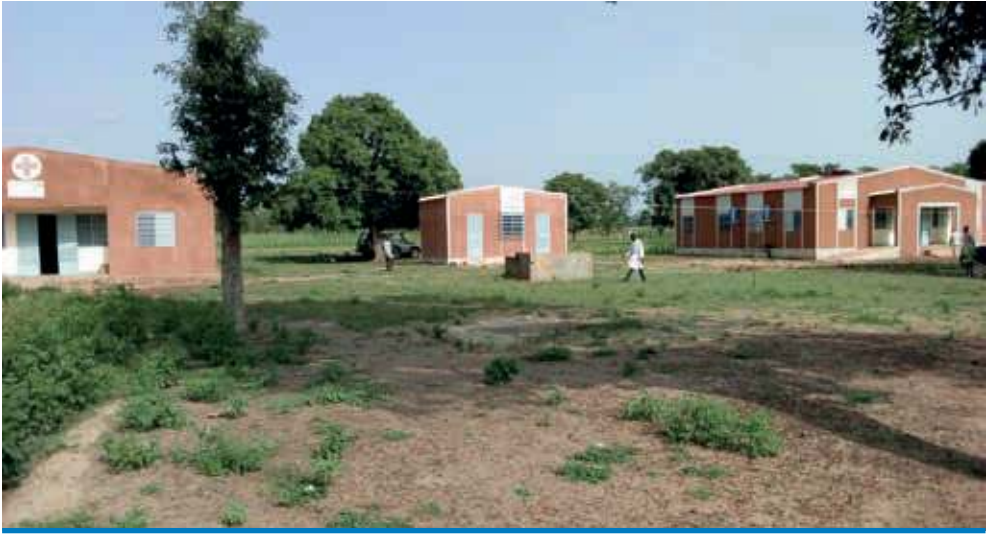
Réhabilitation du CHPS de Lamba dans la Commune de Satiri, Province du Houet
