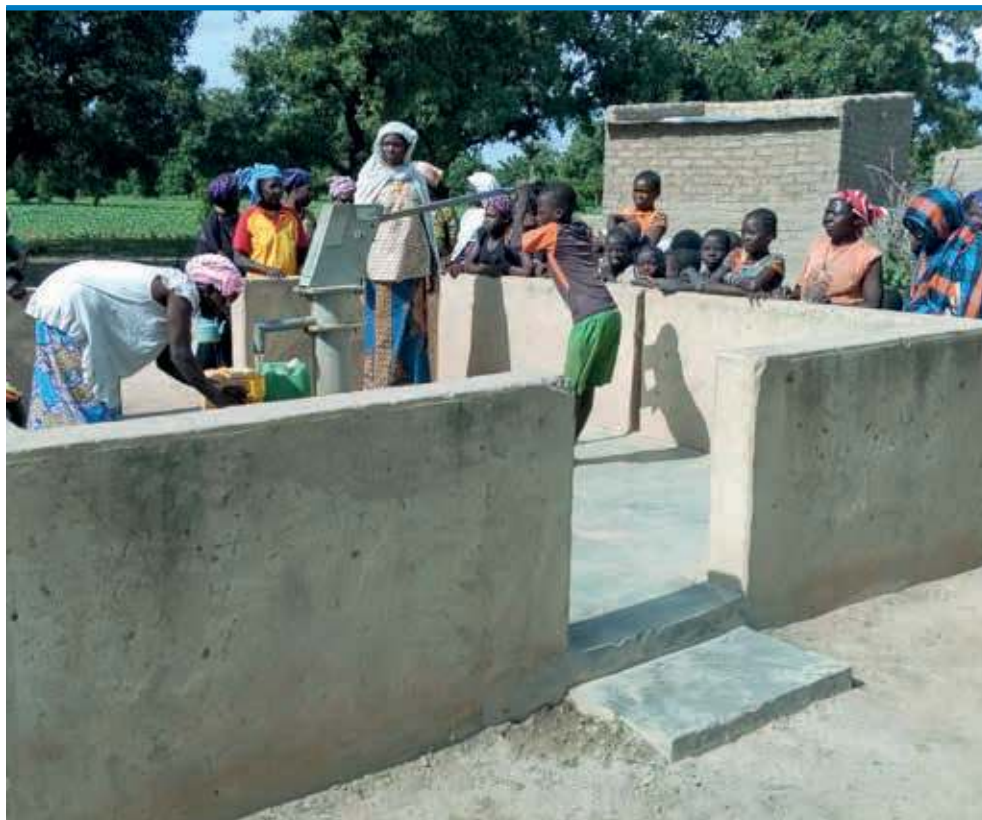
Forage au village de Toghin dans la Commune de Bingo, Province du Boulkiemdé
