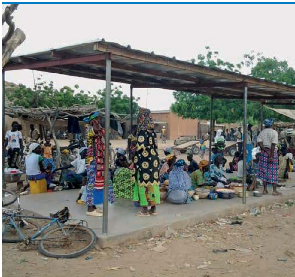
Hangar réalisé à Tibou dans la Commune de Sollé, Province du Lorum
