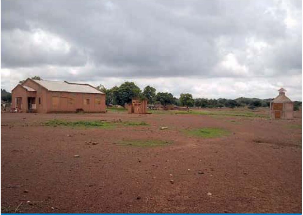
Latrines et incinérateur installés au centre de santé de Bargo dans la Commune d'Absouya, Province de l'Oubritenga
