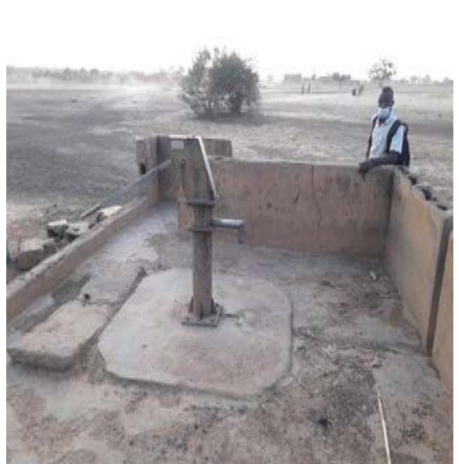
Forage en panne du site de réinstallation de Dourou
