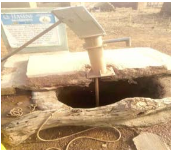
Puits du site de réinstallation Yalou
