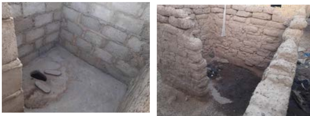
Photo 3 : Situation des latrines sur le site d'accueil de Dourou
