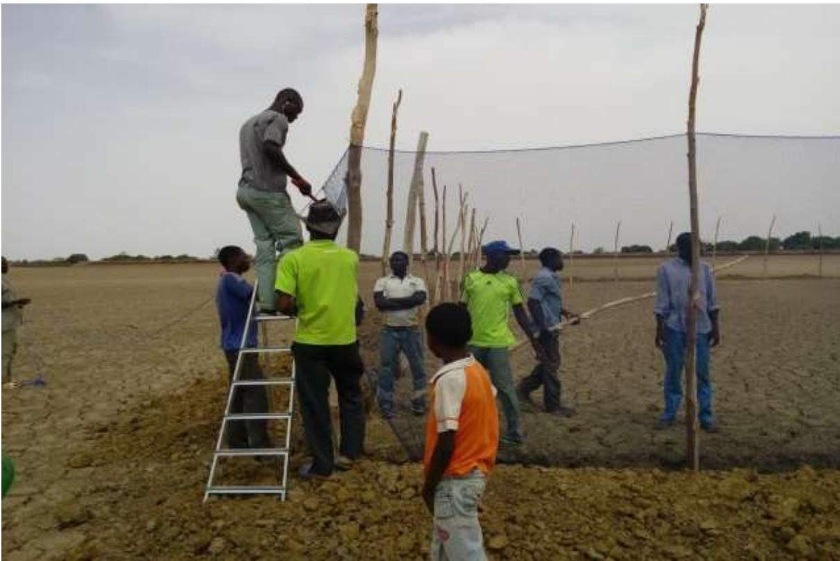
Photo 9 : Enclos piscicole en construction
