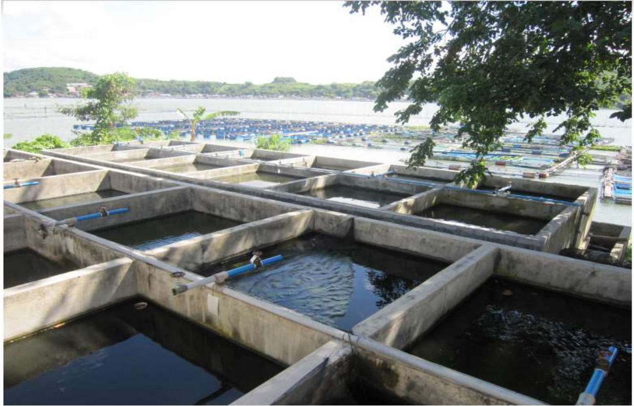
Photo 1: bassins en béton armé
