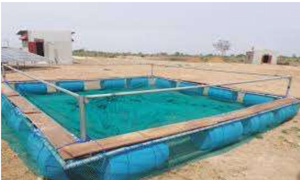
Photo 14 : cages en construction
