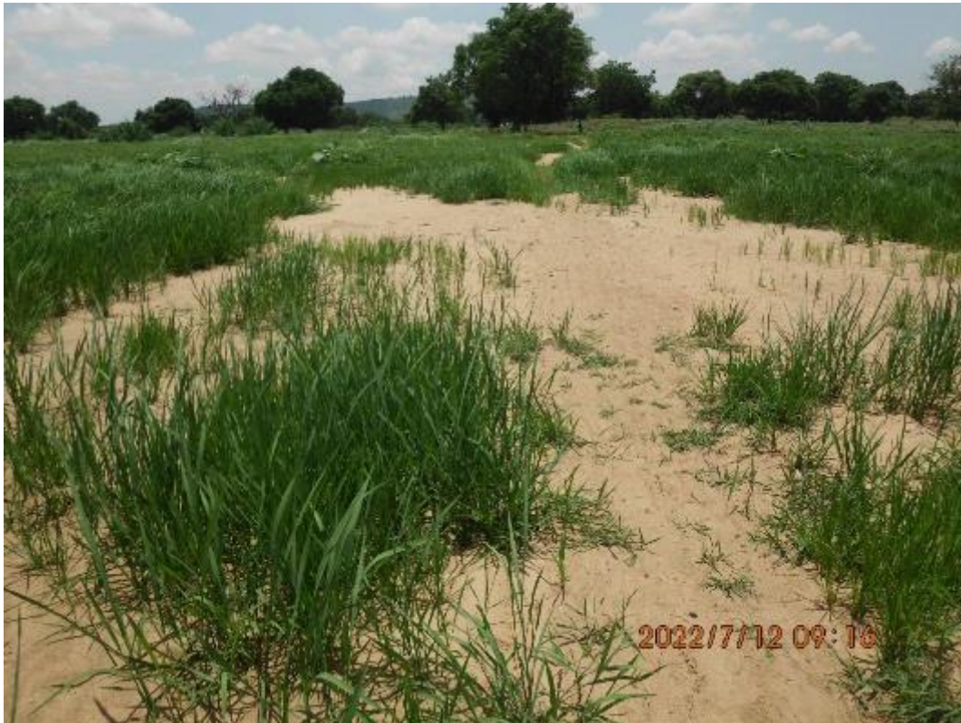
Photo 2 : Ensablement du barrage
