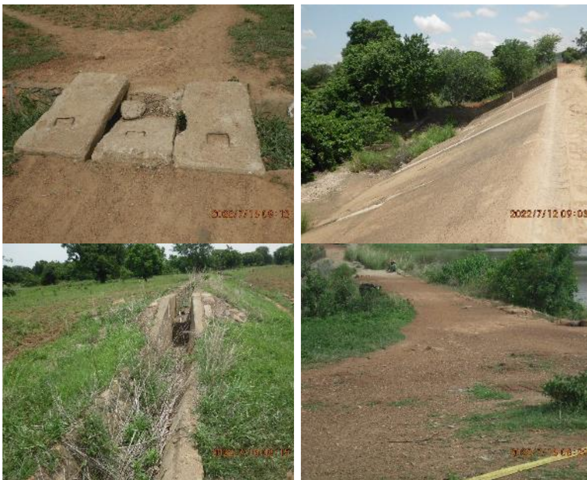
Photo 1 : Etat actuel des infrastructures
