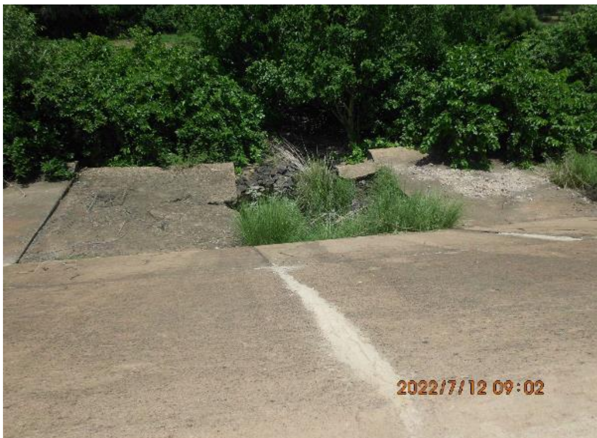
Photo 4 : État du déversoir
