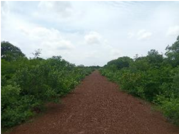
Photo 1: Vue de la digue, le 13/07/2022
