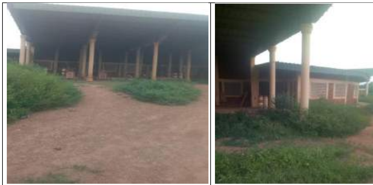
Source : IGIP Afrique, photo terrain, août 2021
