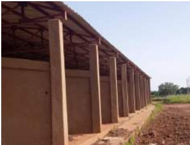
Photo 1: État des hangars réalisés par le PAFASP
