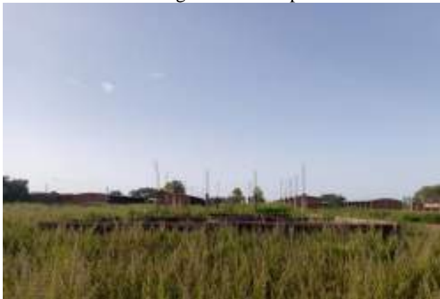
Photo 3: Etat des infrastructures non achevée
