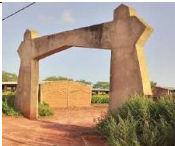
Photo 7: Entrée principale non achevée
