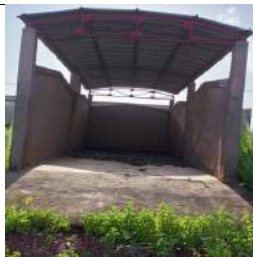
Photo 8: Entrepôt en finition
