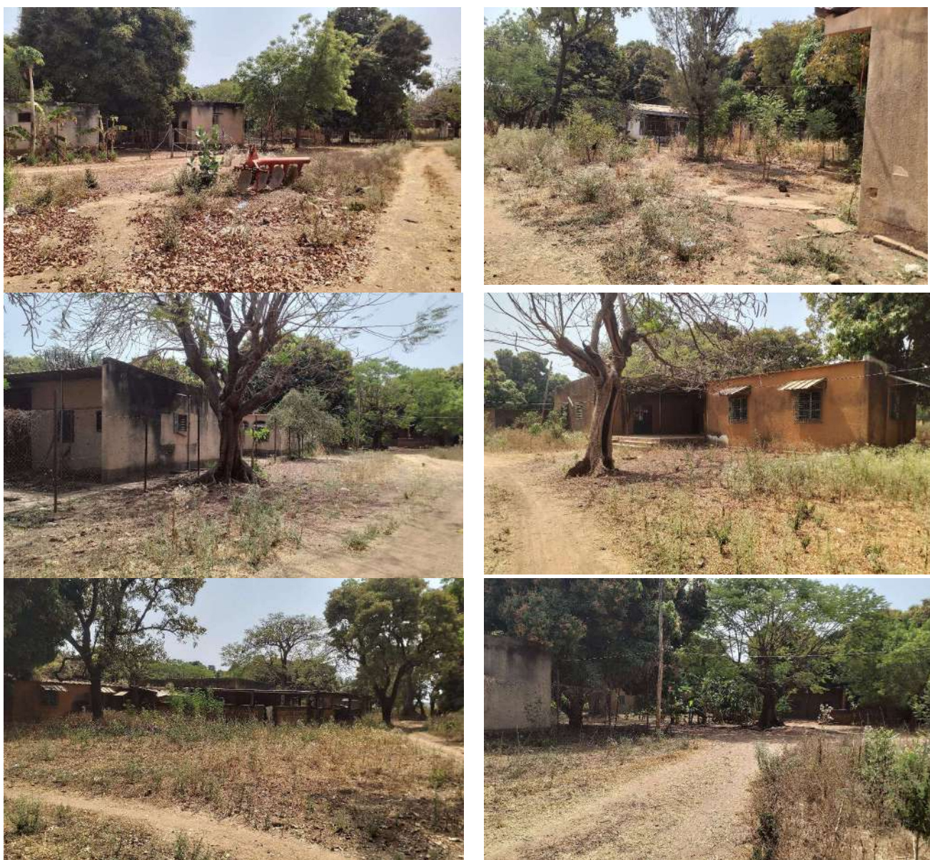
Photo 6 : Vue de quelques installations du site identifié pour servir de base-vie
