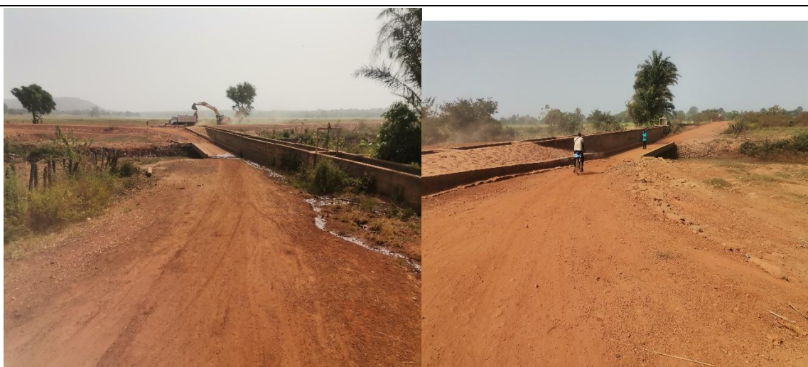
Photo 4. Dalot de traversée au niveau du pont canal
