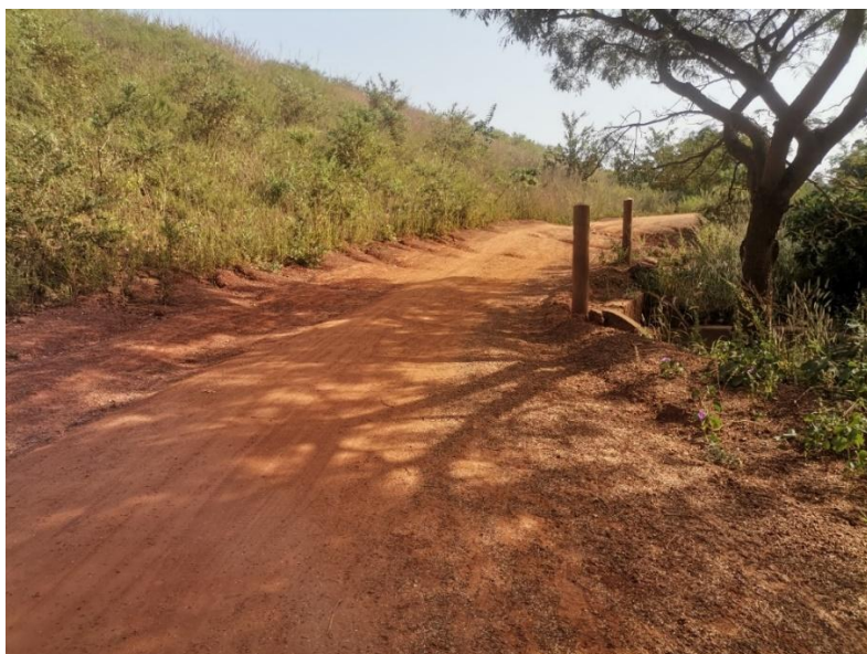
Photo 7. Piste au niveau de l'ouvrage d'évacuation à demi-fond
