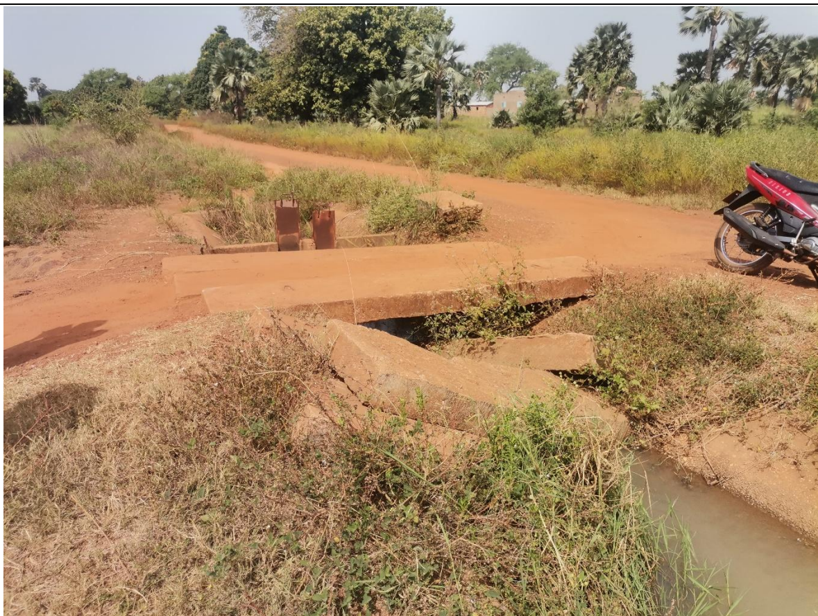
Photo 1. Dalettes détruites par les véhicules poids lourds
